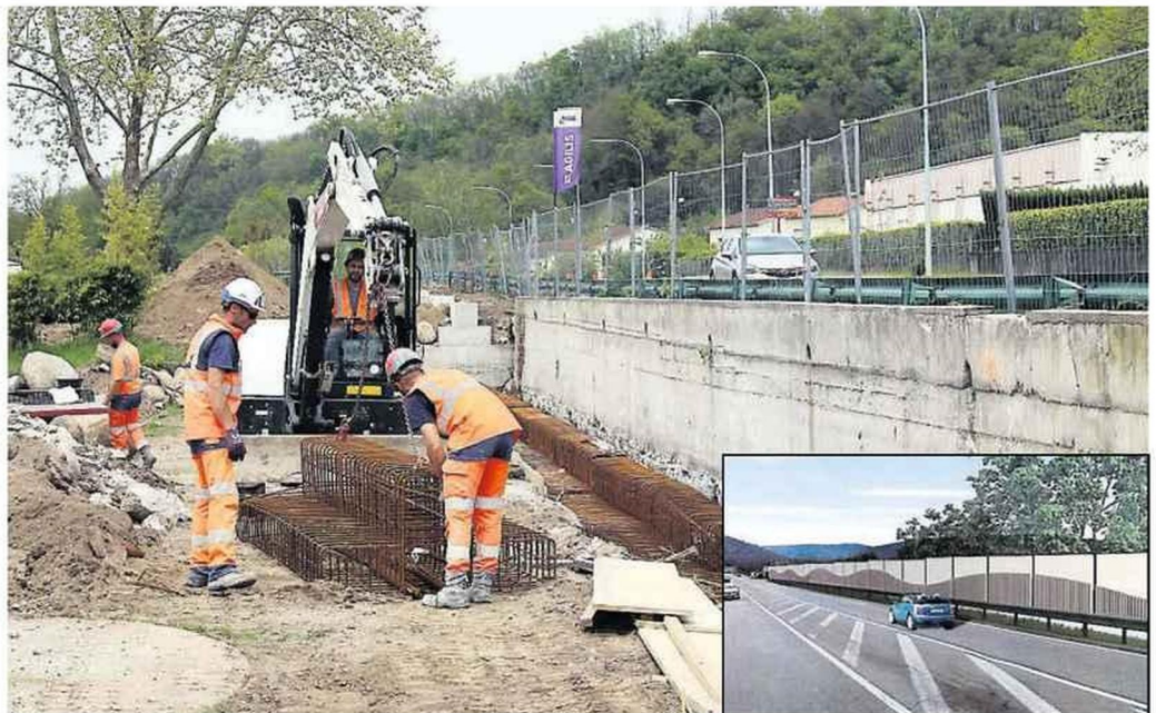
Les fondations du futur mur antibruit sont en cours de finalisation par les équipes d'Agilis./ Photo DDM, O.O.
