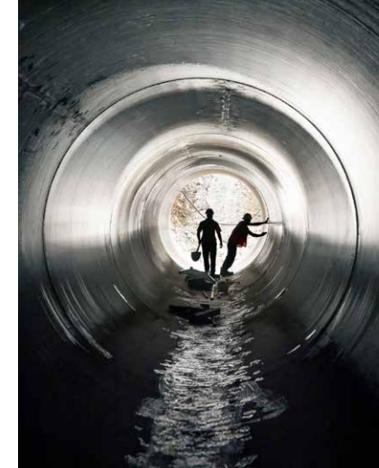
Création de 200 mètres linéaires de réseau d'eaux pluviales en DN2800 à Villeneuve-les-Avignon (30)
