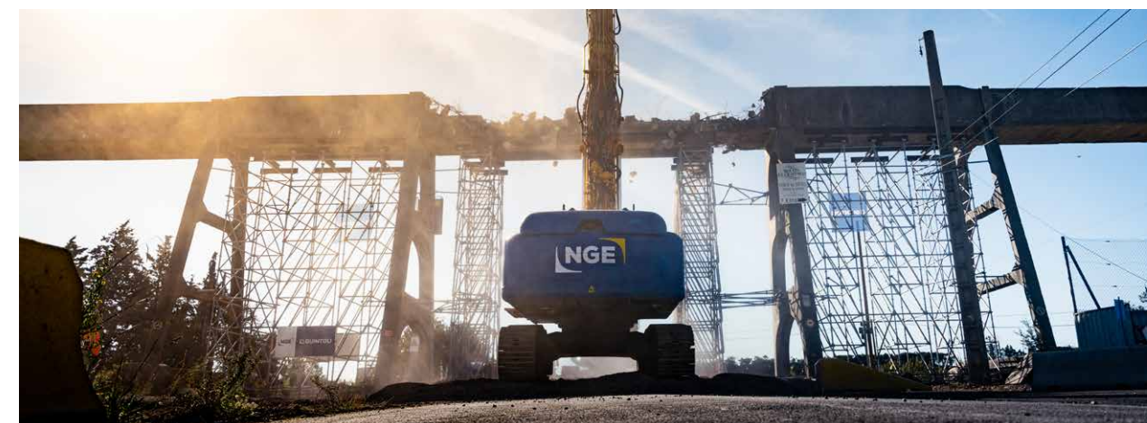
Déconstruction de l'aqueduc de la Fourbine à Saint-Martin-de-Crau (13)
