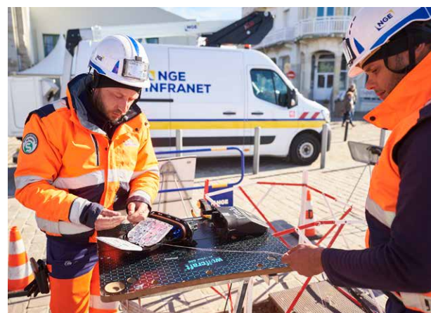
Déploiement de la fibre optique en Aquitaine
