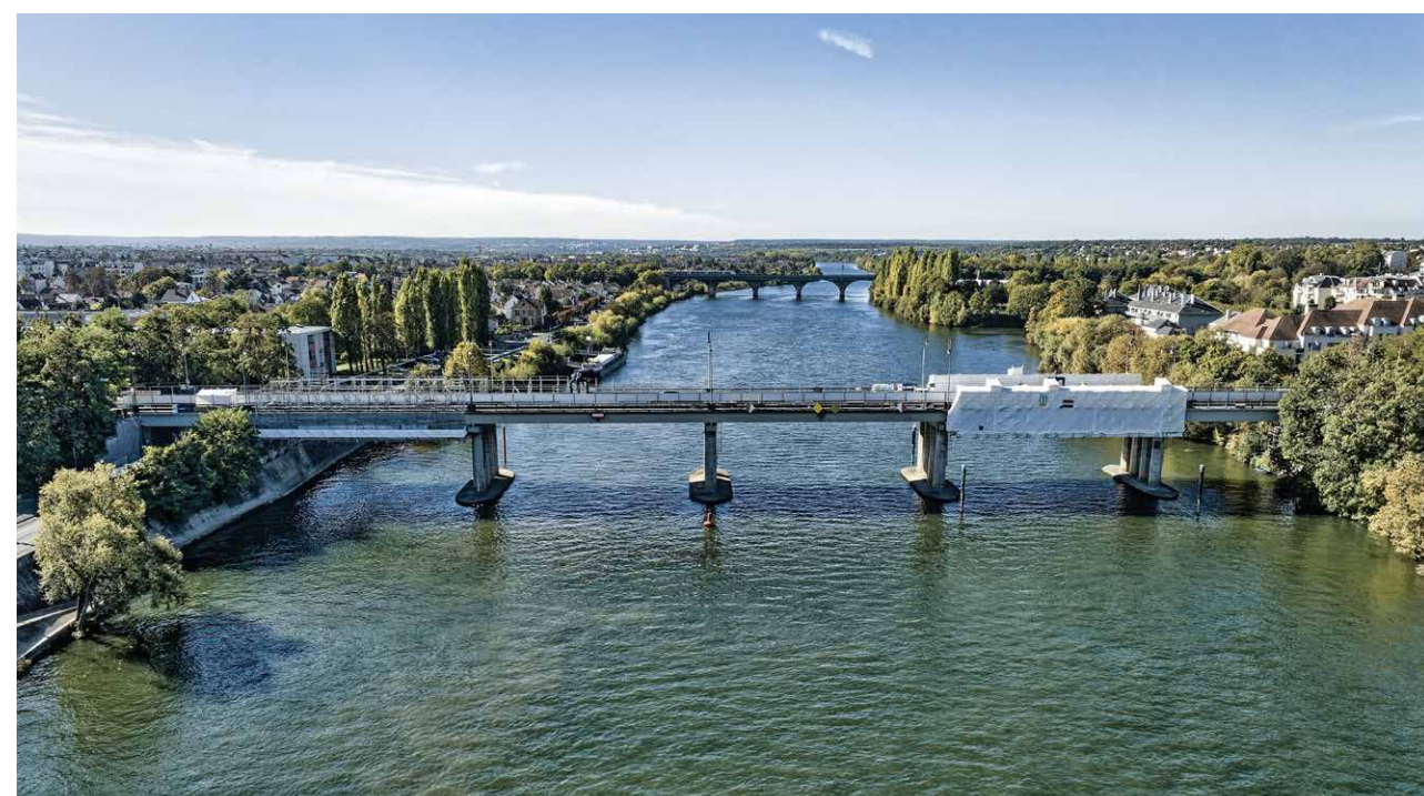
Rénovation du pont de Maisons-Laffitte (78)
