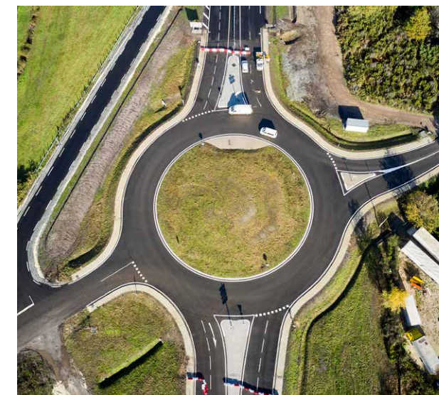
Déviation du Taillan - Médoc (33)
