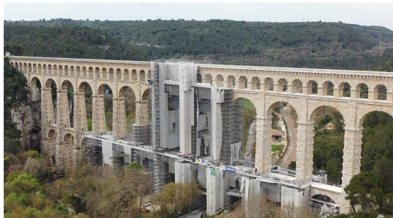
Rénovation de l'aqueduc de Roquefavour (13)
