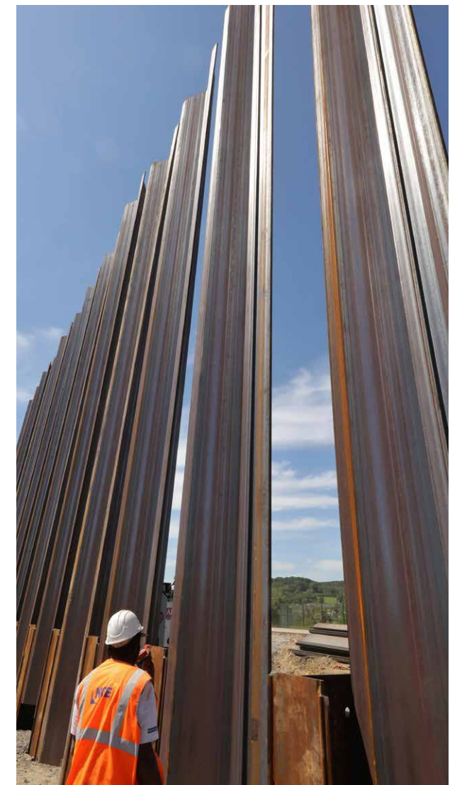
Réalisation des premiers quais du Canal Seine Nord Europe (60)
