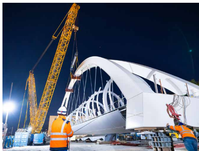
Pose de la passerelle d'Hazebrouck (59)
