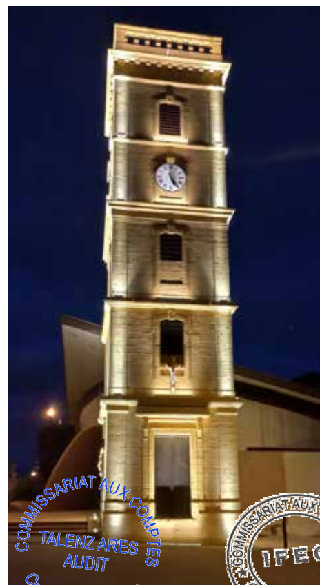
Mise en lumière du clocher de Lexy
