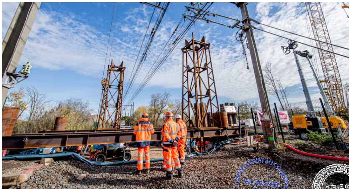
Création d'un passage à niveau dans l'Hérault
