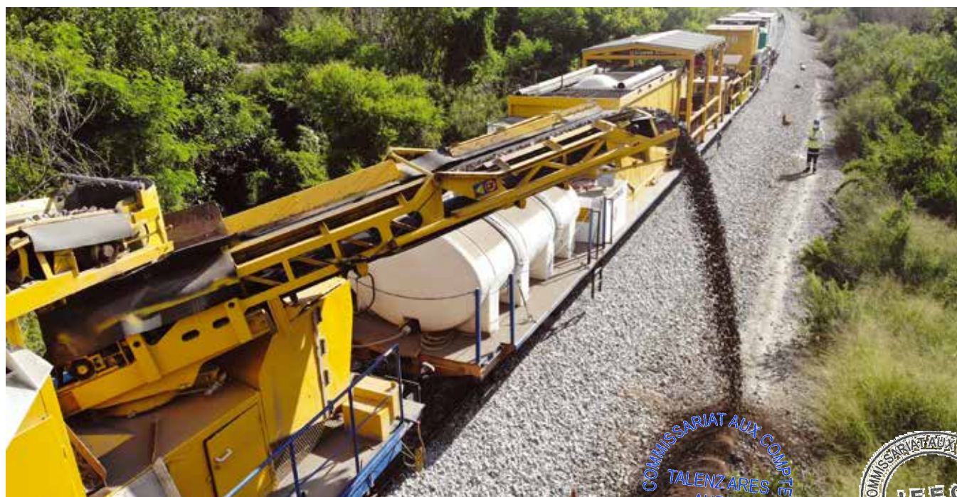
Travaux ferroviaires au Mexique
