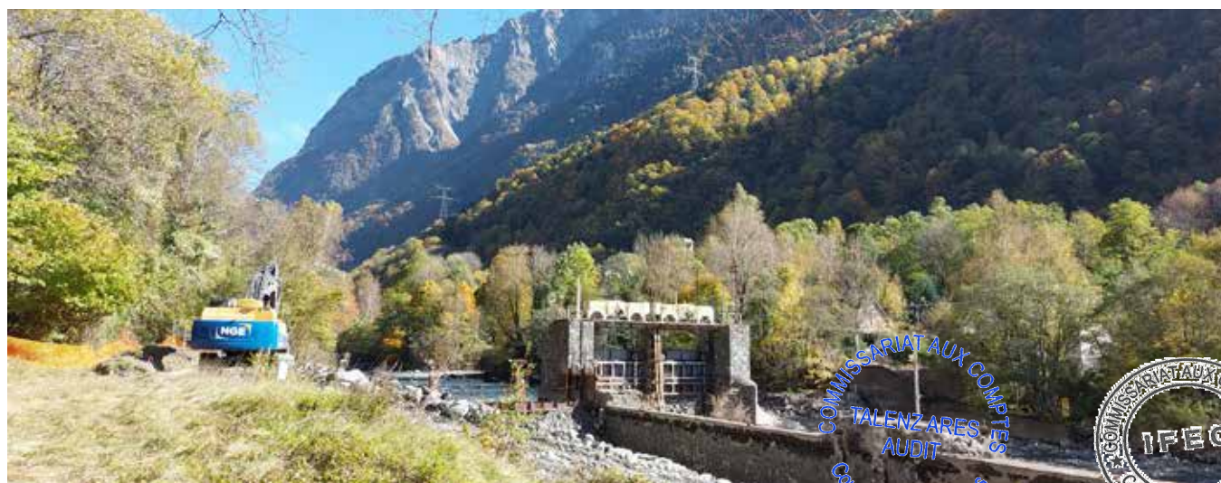
Travaux de renaturation en Moyenne Romanche
