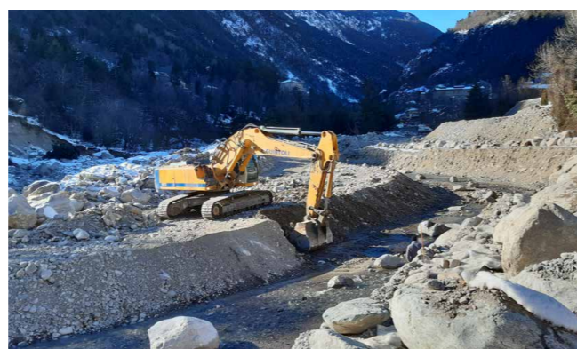
Trabajos de restauración en el Romanche Medio
