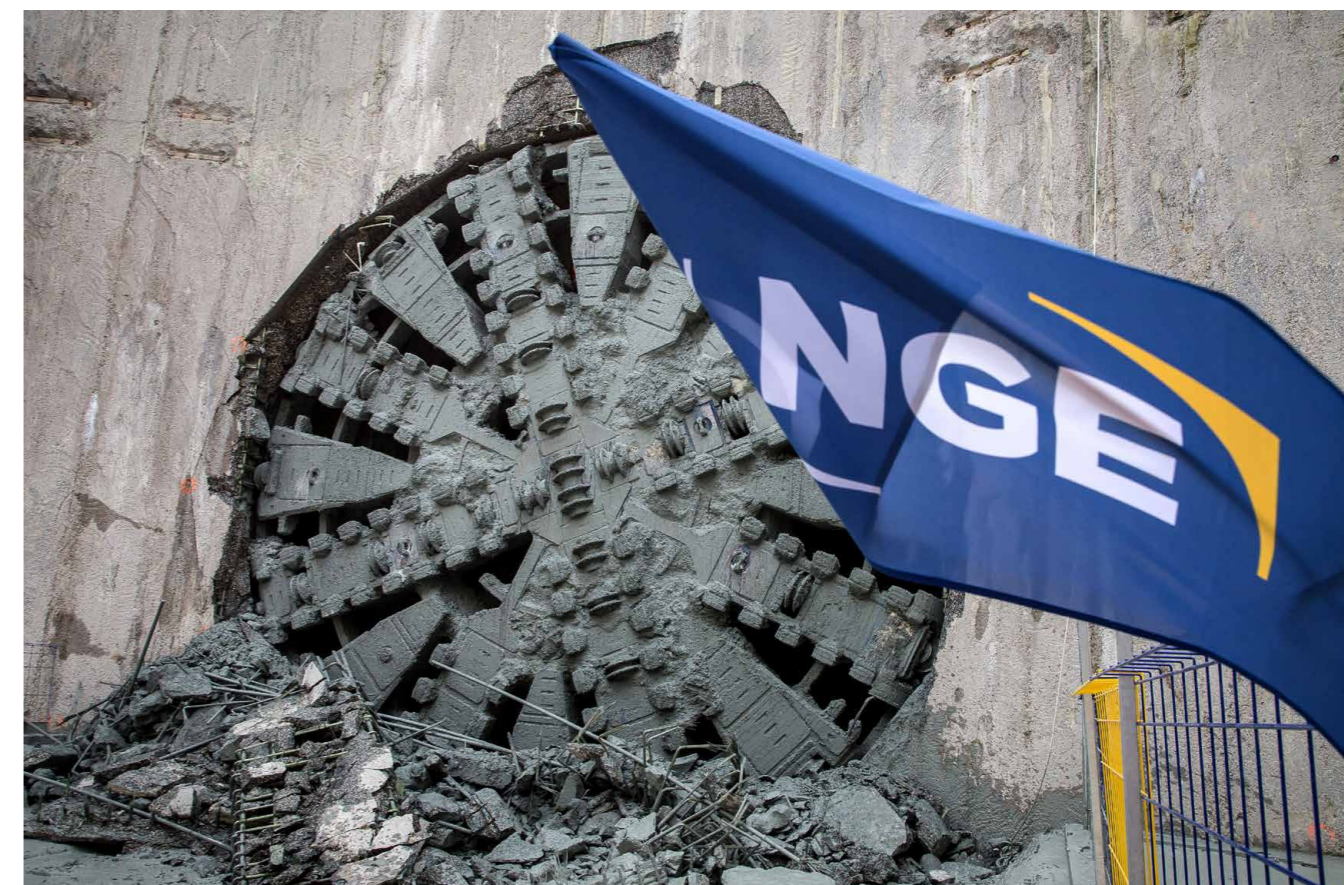
Grand Paris Express - Línea 16 - Perforación de la tuneladora Mireille
