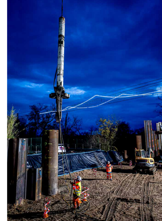
Sitio de construcción PN288
