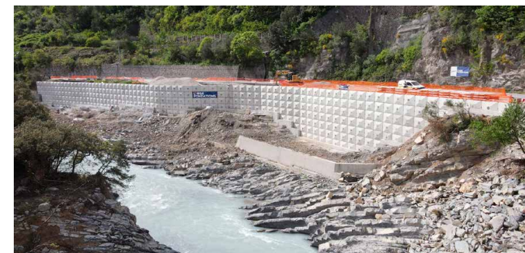
Paroi clouée AD/OC®, Roya
