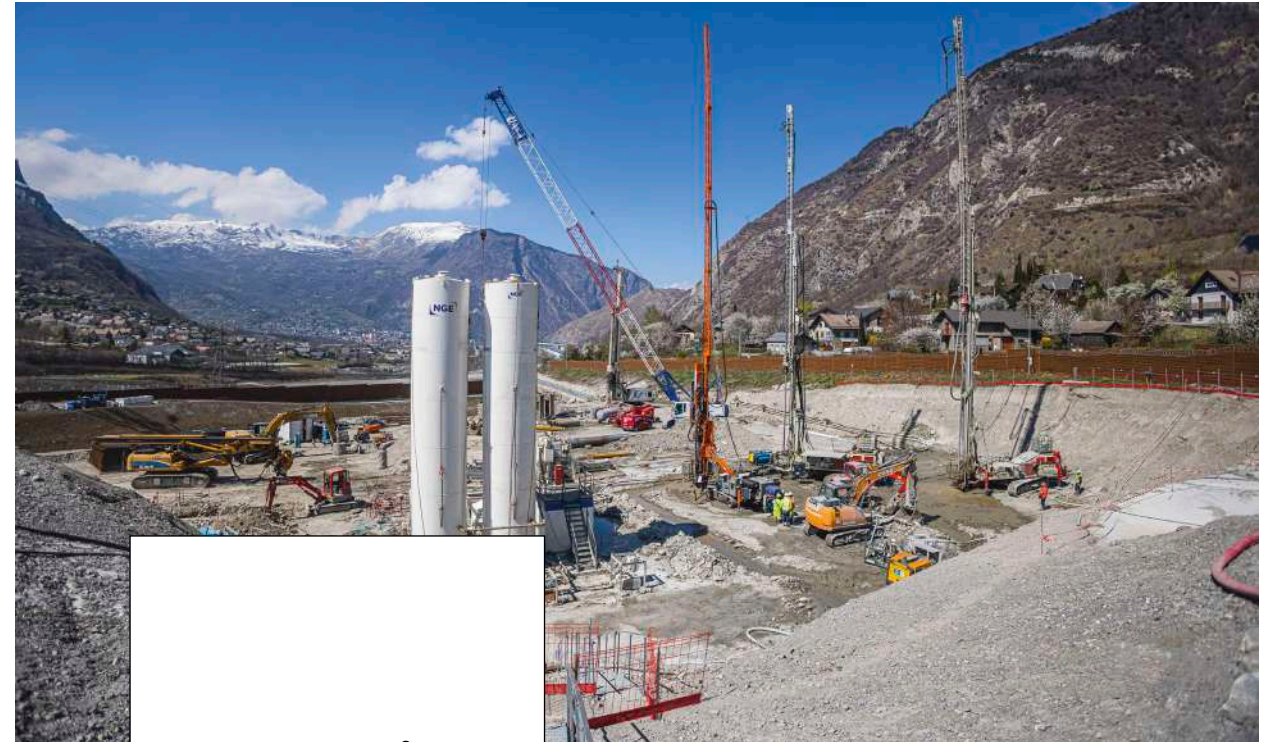
Travaux préparatoires pour le lot 3 du tunnel Lyon-Turin
