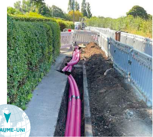
Premières tranchées pour déployer la fibre optique à Liverpool
