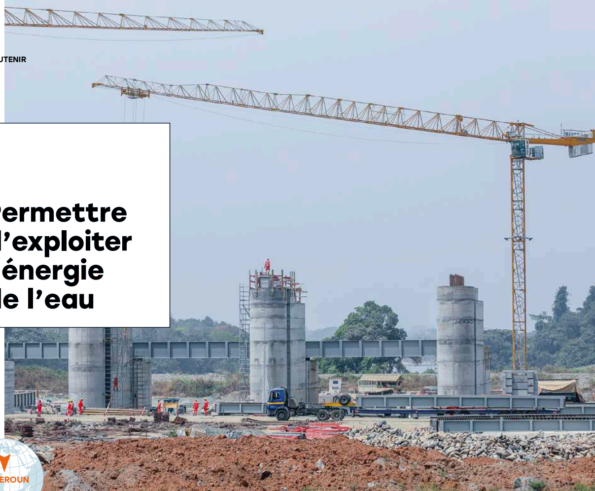
Pour la construction de l'ouvrage hydroélectrique de Nachtigal (Cameroun), mise en place de pertuis temporaires pour faire passer l'eau du fleuve Sanaga pendant la phase de chantier
