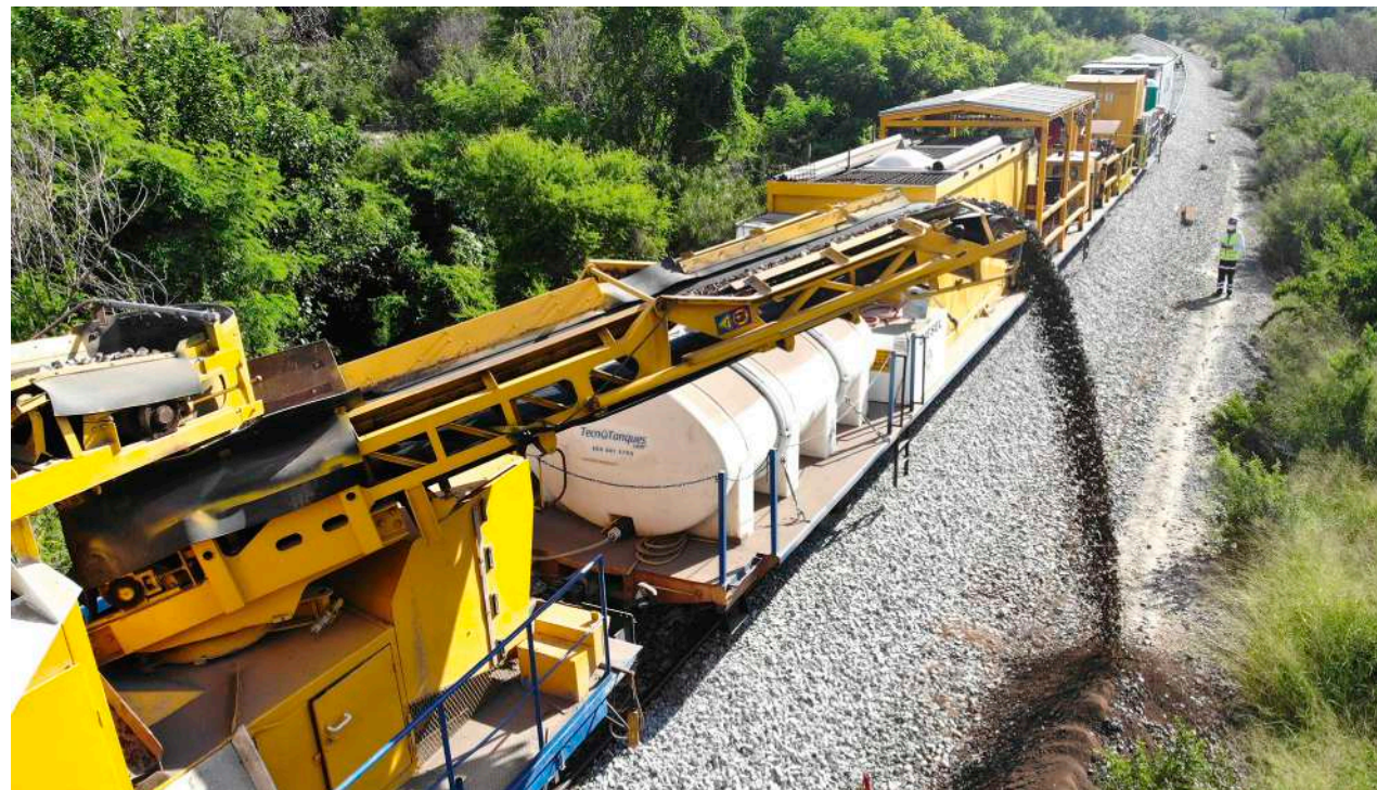
Travaux ferroviaires au Mexique
