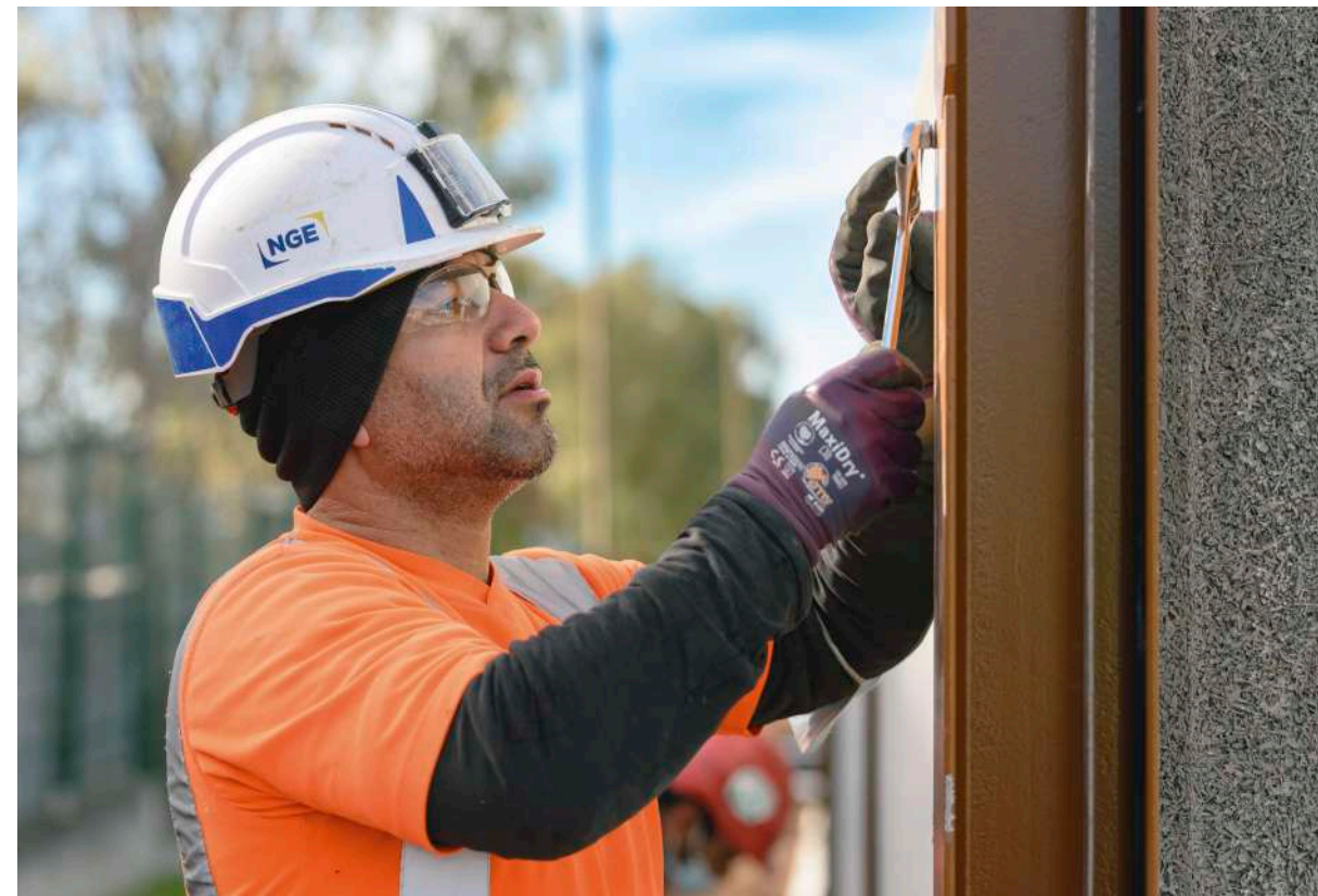
Mise en place des écrans acoustiques ▲ sur l'A57
