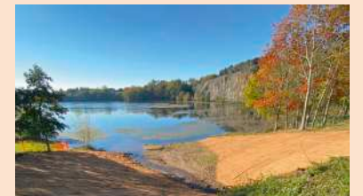
► Opération de génie végétal à Nantes
