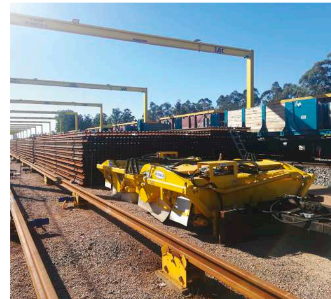
Installation de poutres de pont ferroviaire et déchargement de machines
