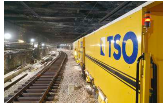
Opération coup de poing pour la modernisation du RER C
