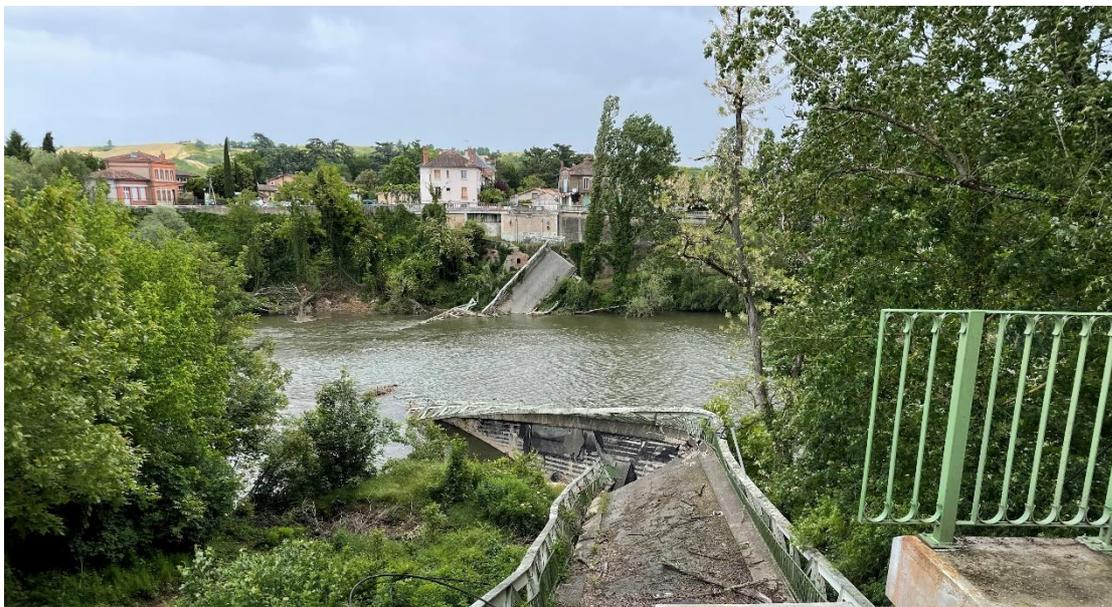
Les parties aériennes du pont (pylônes, câbles, rattachements aux ancrages de part et d'autre) ayant été démontées, NGE va s'atteler à la 2<sup>nd</sup>e partie délicate qui est d'extraire 600 tonnes d'acier et de béton (poids du tablier), échouées au fond du Tarn, ainsi que le camion.
