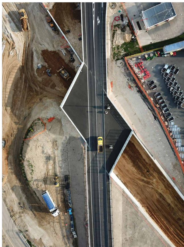
▲ Modernización de la línea Serqueux-Gisors (27)
