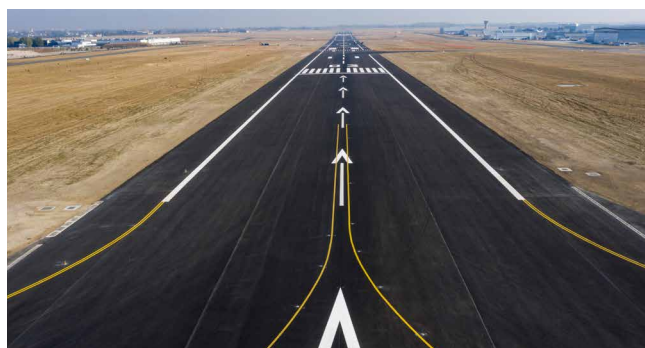
▲ Renovación de la pista del aeropuerto Paris Le Bourget
