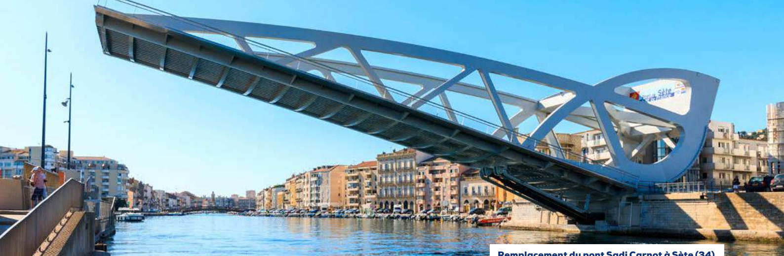
Remplacement du pont Sadi Carnot à Sète (34)
