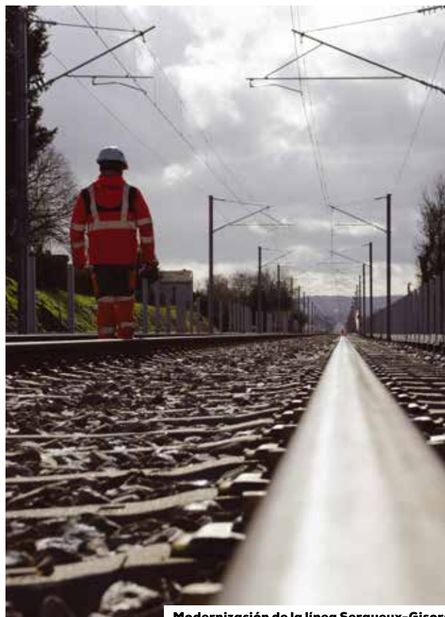
Modernización de la línea Serqueux-Gisors
