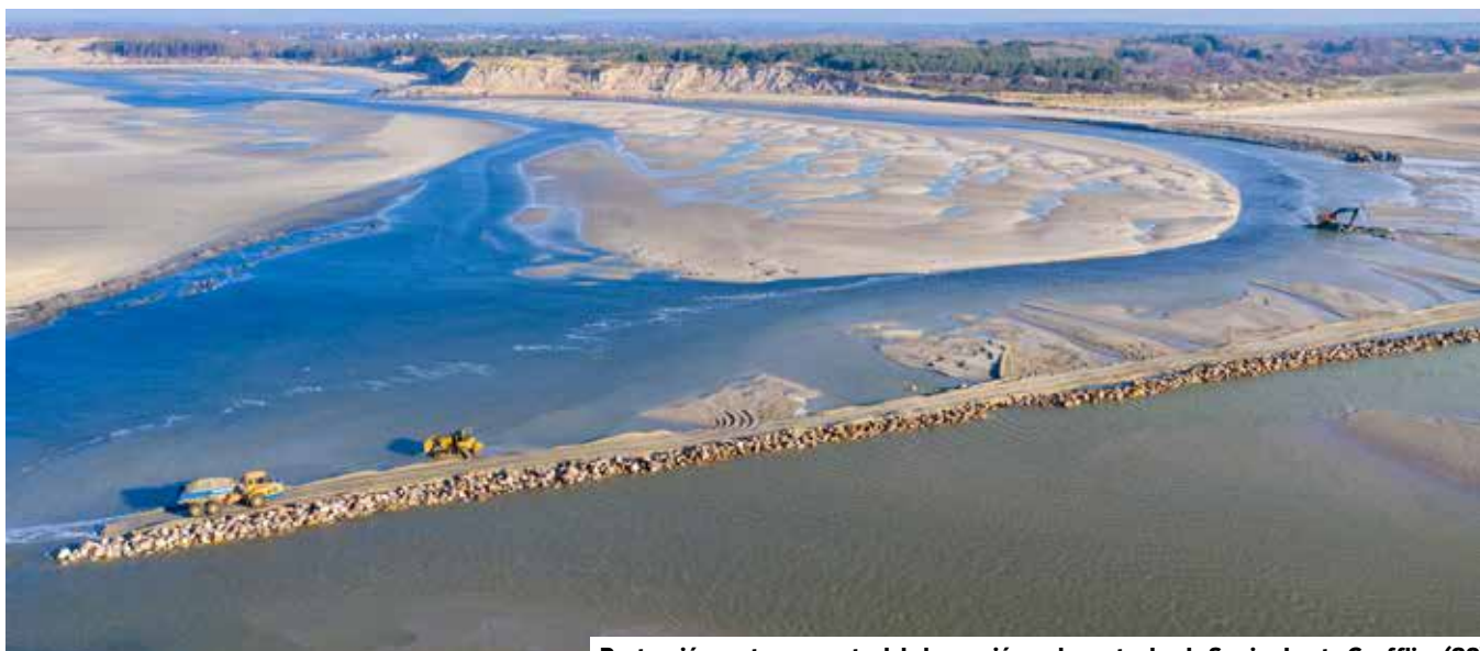
Protección costera y control de la erosión en la costa desde Sapins hasta Grofflier (62)
