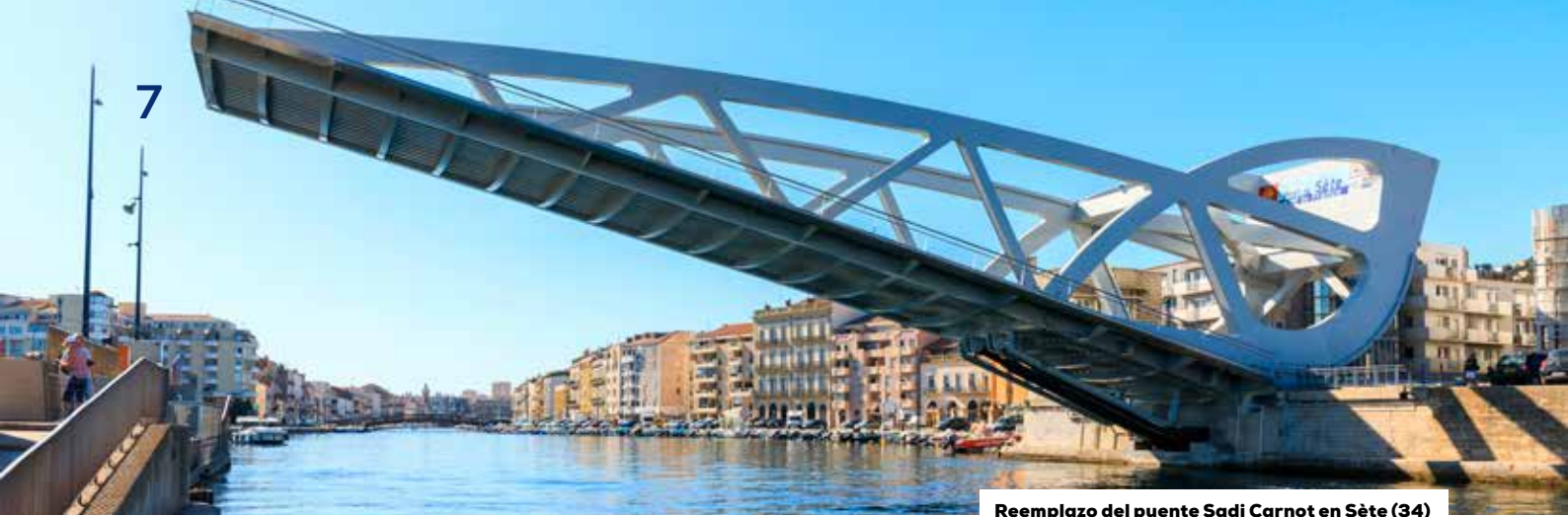
Reemplazo del puente Sadi Carnot en Sète (34)
