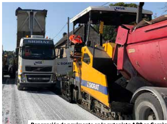
Reparación de pavimento en la autopista A20 en Corrèze
