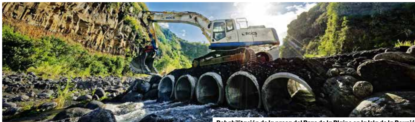
Rehabilitación de la presa del Bras de la Plaine en la Isla de la Reunión
